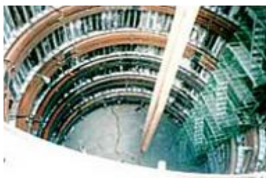
下水道工事 立杭H鋼 ガイドリング
