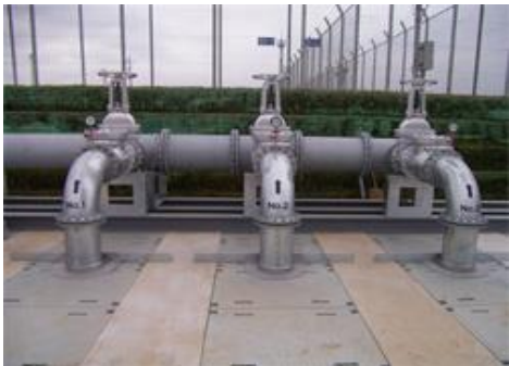
内面ポリエチレンライニング鋼管 (WSP-039 FPB)
