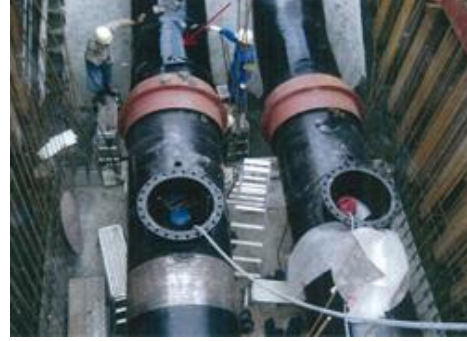
中継部の現地ライニング(内面)
