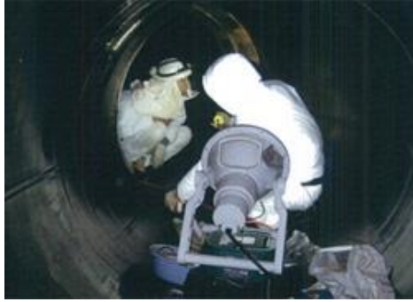
収縮シートによる現地ライニング(外)
