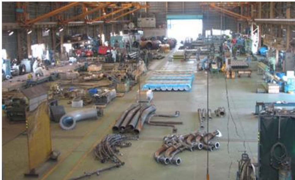
プレファブ工場全景
