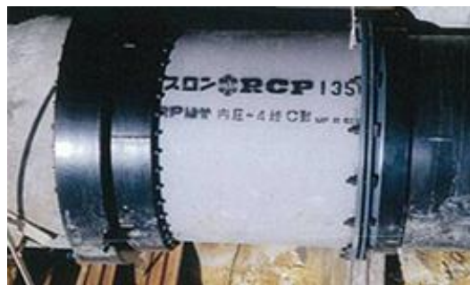
PC管とRCP管の接続
